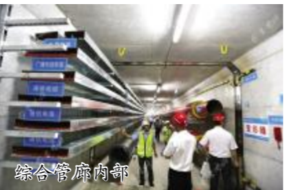
综合管廊内部
