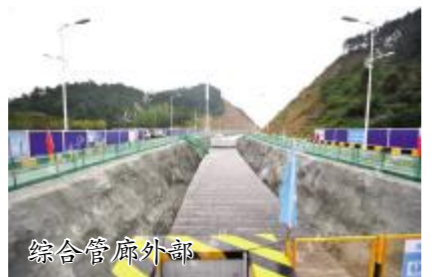
综合管廊外部
